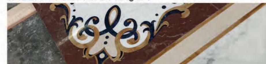
Il taglio del marmo con waterjet è una tecnologia che offre elevatissima precisione e infinite possibilità creative, permettendo la realizzazione di intarsi, elementi di arredo e tagli di precisione in generale. Ideale per progetti architettonici di altissimo pregio.
