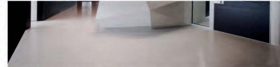
**MICROCEMENTO:** perfetto per chi desidera una superficie continua e materica, con soli 3 millimetri di spessore. Il microcemento permette di rinnovare superfici esistenti su differenti supporti (calcestruzzo, ceramica, legno) senza necessità di rimuoverle.
